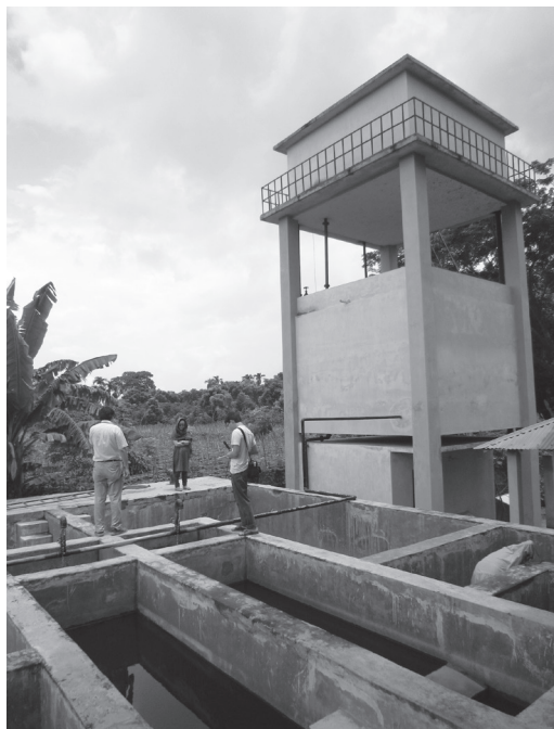
写真4 JICAプロジェクトで建設した 地域水道
